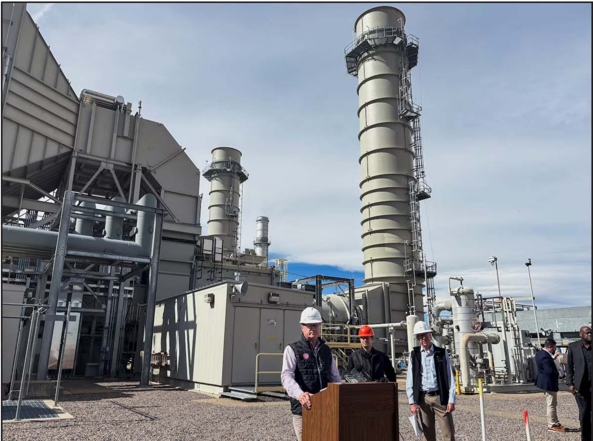
EL secretario de Energía, Chris Wright, en una planta de gas en Colorado.
